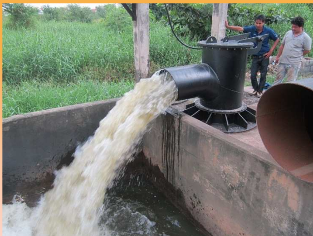
งานติดตั้งปั๊ม 22 kW สถานีสูบน้ำฝน
