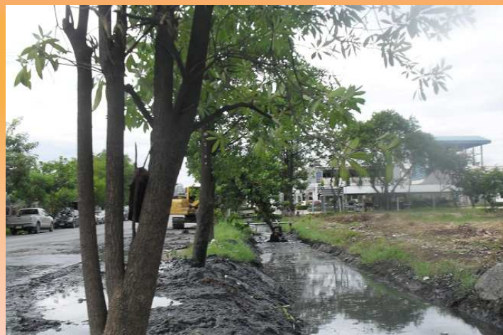
งานขุดลอกรางระบายน้ำฝน
